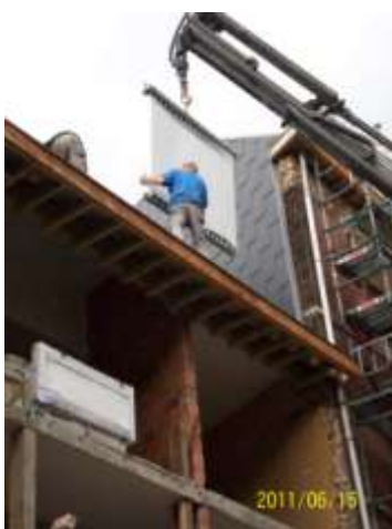
Installation des panneaux solaires pour le chauffage
